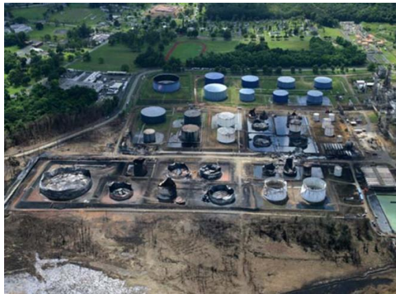
Danos à instalação após o incêndio
