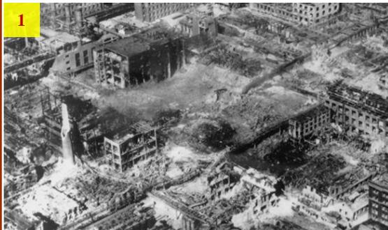
Em Julho de 1948 um caminhão tanque carregado com éter dimetílico (DME) chegou em uma fábrica em Ludwigshafen, Alemanha. Ele estava estacionado ao sol há cerca de 10 horas quando provavelmente uma costura de solda falhou. Morreram cerca de 200 pessoas, quase todas pela explosão da nuvem de vapor inflamável de DME criada pelo vazamento. Cerca de 4.000 pessoas se feriram, a maioria pela exposição às substâncias tóxicas que escaparam de instalações danificadas pela explosão (Figura 1).
