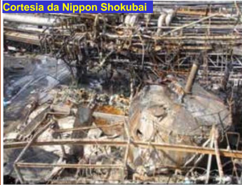
Figura 1: Tanque de AA destruído
